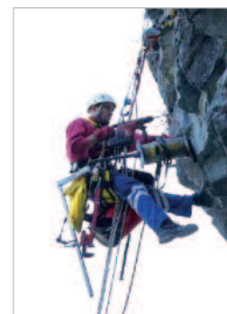
Essai de traction sur ancrage
