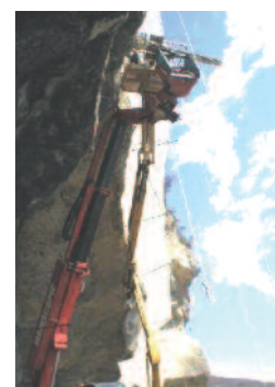
Sondage carotté horizontal en falaise Saint-Pancrasse (38)
