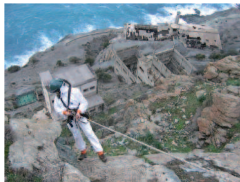
Diagnostic stabilité ancienne carrière d'amiante Canari - Haute Corse (2B)
