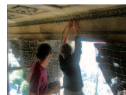
Localisation d'armatures au Panthéon
